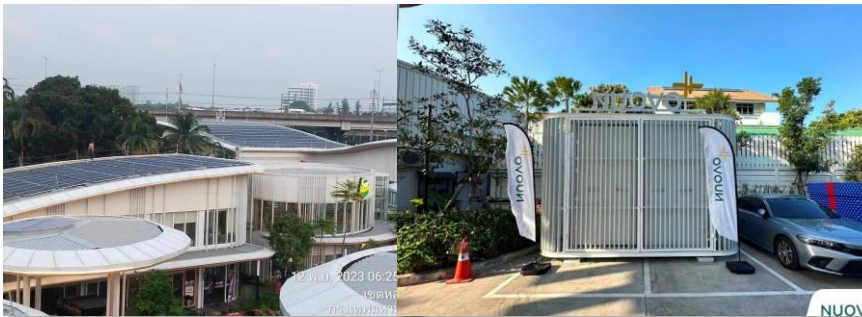
รูปภาพ Solar Rooftop และ Battery Energy Storage System และ LEED Certification ของร้าน Café Amazon
